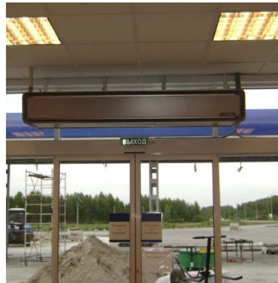
Тепловая завеса с водным нагревателем. Двери открываются автоматически
